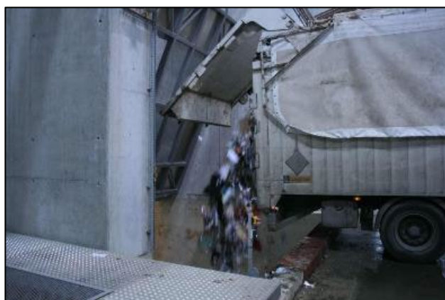
Figure 6 : Déchargement d'ordures ménagères en fosse
